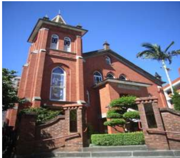
圖4-20 禮拜堂建築採「加強磚造」仿哥德形式扶壁，柱頭飾以小帽尖，四周開尖拱型窗戶，以進口彩色玻璃透出莊嚴神聖之氣氛
