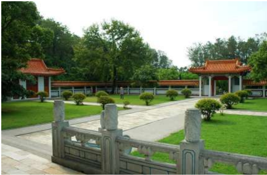
圖4-31 為了改建為現今的「淡水忠烈祠」，原淡水神社內外部的建材都已拆毀，只剩牌樓底下那一段石階，以及石階圍出來的一個圍牆。
